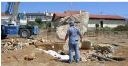
Figura 5 – Transporte e reposicionamento do esteios de cabeceira.
