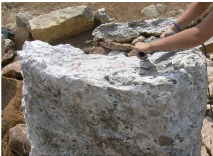
Figura 7 – Pormenor da limpeza das superfícies a colar.
