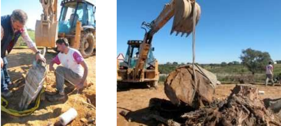
Figura 15 – Pormenor de acções de referênciação e desmonte dos esteios.
