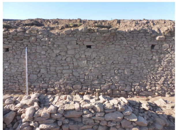
Figura 4 – Pormenor do alçado e dos orifícios para disparo de armas de fogo.
