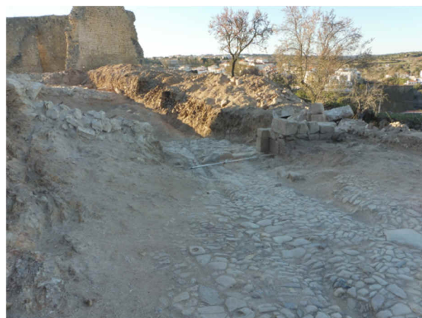
Figura 18 – Perspetiva interior sobre a porta de acesso ao interior da liça..
