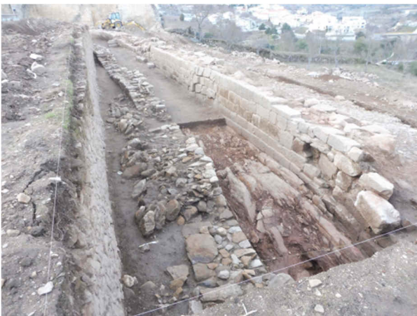
Figura 8 – Zona intramuros. Vista de SW. Alçado Sul da muralha.
