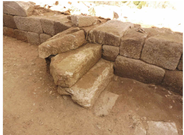
Figura 10 – Escadas de acesso ao adarve.
