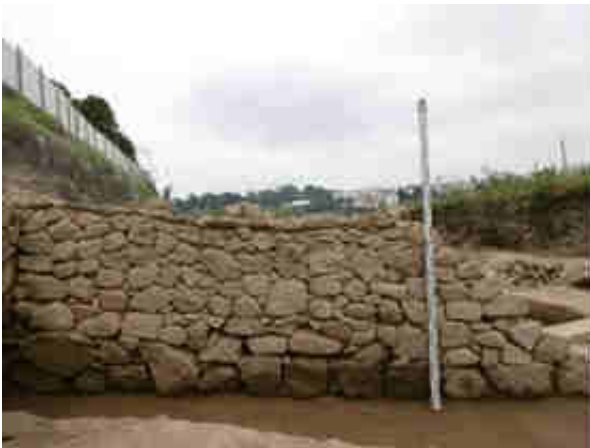
Figura 15 – Muro divisório, com uma fiada regular a encimar o aparelho.
