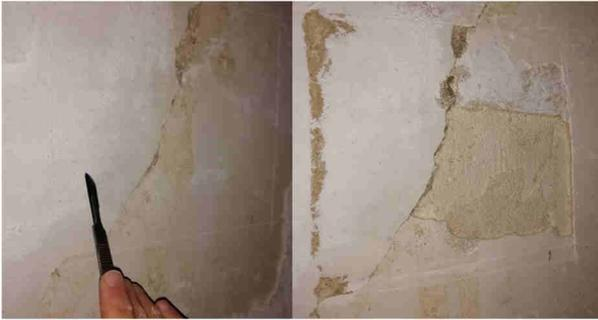
Figura 5 – Início da abertura de janela de sondagem A1.
