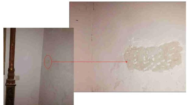
Figura 13 - Reboco recente e compacto à base de cimento branco.
