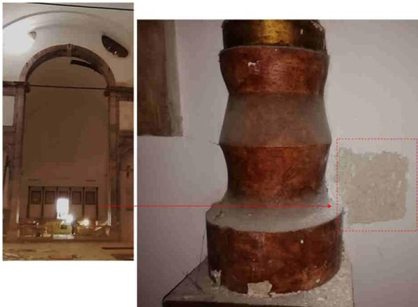
Figura 11 - A6 revela um reboco compacto à base de cimento branco.
