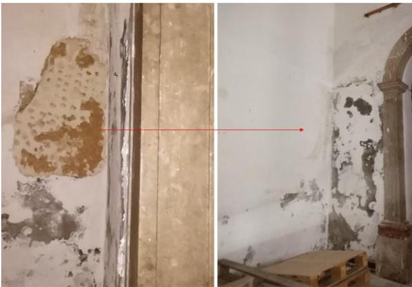
Figura 6 – Alargamento da zona de sondagem ao lado da janela A1, com camada de reboco fina, mas sem vestígios de camadas decorativas.
