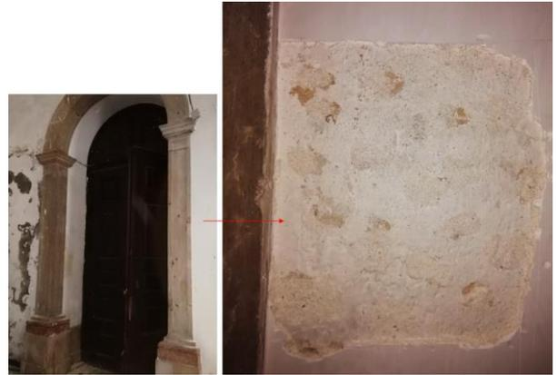
Figura 8 – Sondagem A3, onde se verificou a existência de um reboco recente sobre um reboco antigo muito danificado.
