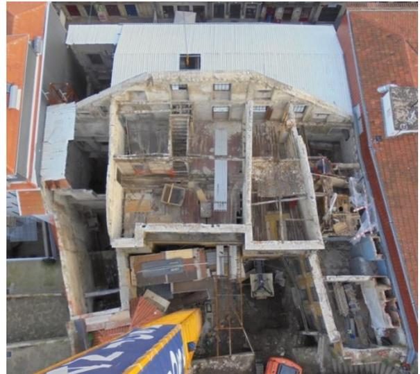
Figura 7 – Vista sobre o Palácio após a desmontagem da cobertura.
