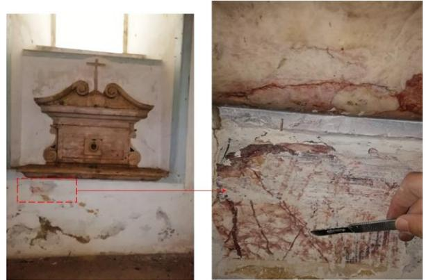
Figura 16 - Paramento onde se realizou a análise estratigráfica A11.
