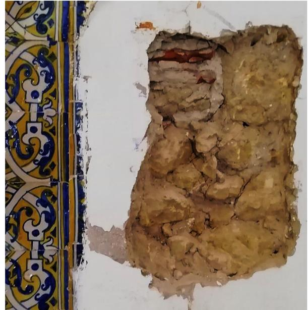
Figura 20 - Aparelho construtivo das paredes (estas sondagens foram realizadas anteriormente à nossa pesquisa).
