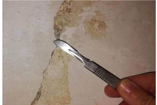
Figura 4 – Exemplo de sondagem realizada *in situ* durante a realização das análises estratigráficas. A técnica utilizada foi o levantamento de camadas superficiais com auxílio de bisturi.
