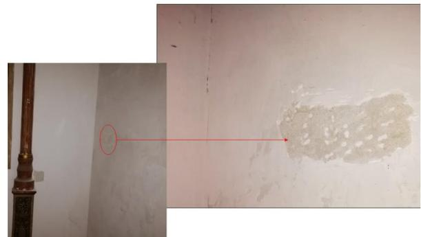
Figura 13 - Reboco recente e compacto à base de cimento branco.
