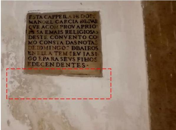
Figura 10 - Zona onde se tentou fazer uma análise estratigráfica, mas devido à camada de reboco cimentícia, extremamente rígida, tal não foi possível.
