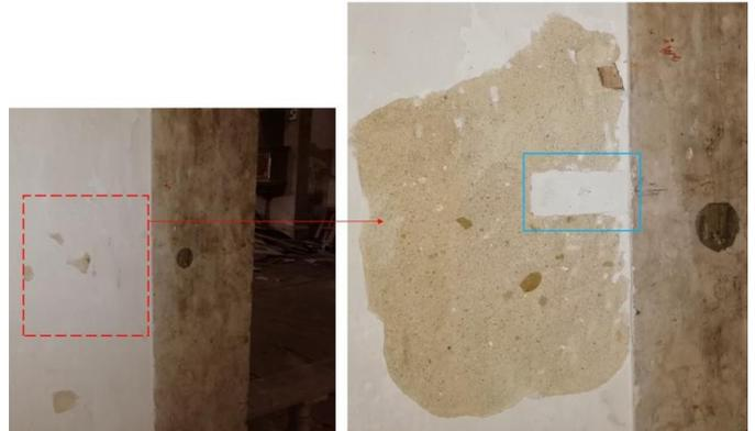
Figura 12 - A azul pormenor de “gato” de ligação entre a cantaria e o reboco.
