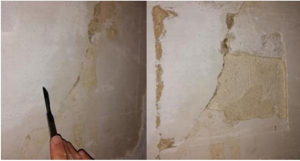
Figura 5 – Início da abertura de janela de sondagem A1.
