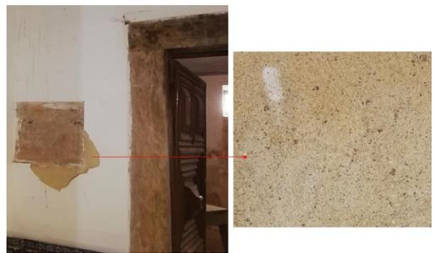
Figura 9 – Pormenor de reboco analisado em A4, onde já não são visíveis camadas de acabamento, mas existe um emboço tradicional à base de cal natural
