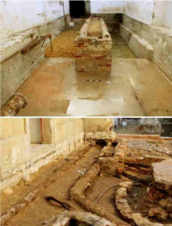
Figura 13 – Vista geral do depósito de água identificado na sala anexa às caldeiras, com tubagens em ferro que dele saem para distribuição de água.
