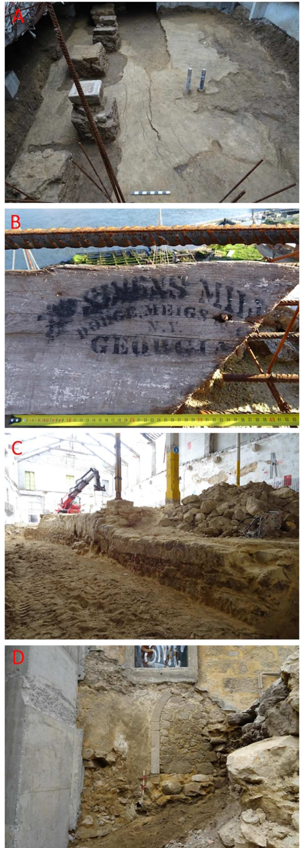
Figura 4 – A - Vista do piso mais antigo identificado no armazém 1; B - Inscrição identificada nas traves da cobertura do armazém 1; C - Parede identificada no Armazém 2; D - Vista do vão do antigo edifício identificado na parede este do Armazém 2.
