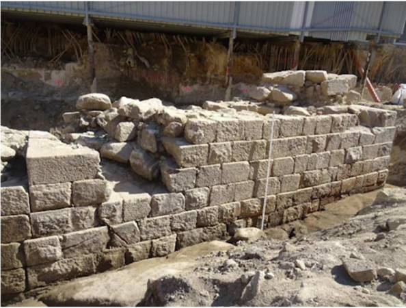
Figura 15 – Alçado Norte do torreão [443] onde é visível a destruição provocada pela construção da galeria do Rio de Vila.
