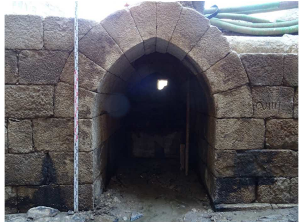
Figura 16 – Galeria em arco ogival, por onde o Rio de Vila atravessaria a muralha.
