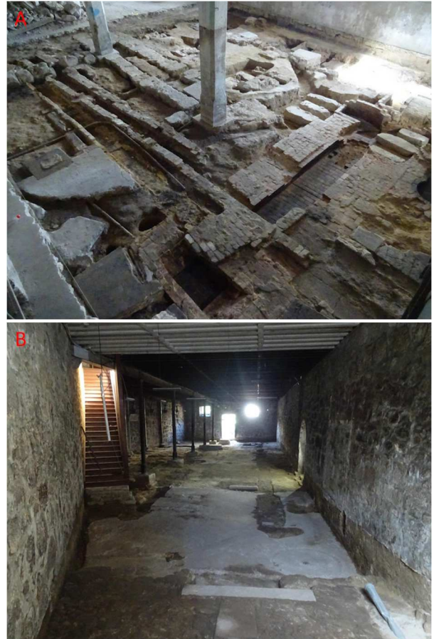
Figura 3 – A - Vista das estruturas identificadas no Armazém 1; B - Vista das estruturas registadas no Armazém 3.
