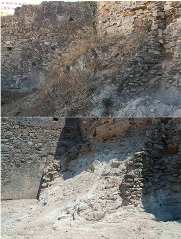
Figura 11 – Aspecto da Torre 10, junto ao cavaleiro de Santo António, antes da escavação (esquerda) e depois da sua limpeza (direita).
