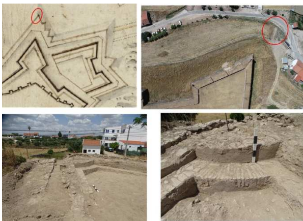
Figura 14 – Localização das estruturas da cerca exterior ao fosso, registadas nas envólucras do baluarte de Santo António.
