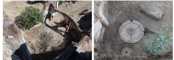
Figura 17 - À esquerda: aspecto da área do Lagar, antes da intervenção. À direita: lagar após a decapagem podendo observar-se a base de uma moenda para a azeitona.
