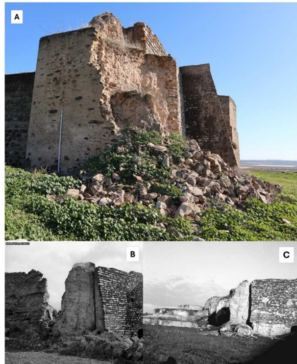
Figura 10 – A) Aspecto da torre 3 antes da remoção dos escombros resultantes da sua ruína parcial. B) Aspecto da área onde se localiza a Torre 3, cerca de 1950. Nesta foto é perceptível que a torre é praticamente inexistente e que a muralha sofreu uma acentuada degradação e se encontra muito fragilizada (Foto SIPA 00156515, 1950). C) Aspecto da área de entulhos, envolvente à Torre 3, em 1985 (Foto SIPA 00156679, 1985).
