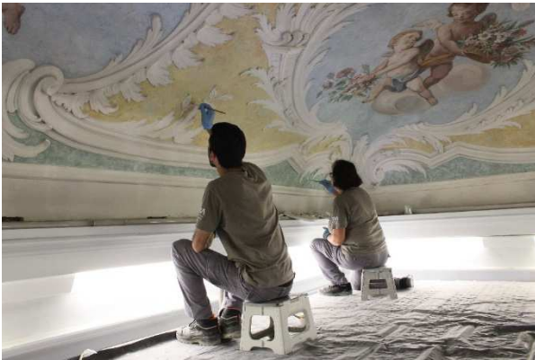
Figura 14 – Processo de reintegração cromática realizada com aguarelas extrafinas da Windsor & Newton®, respeitando, de forma mimética, as cores, tonalidades, texturas e formas dos elementos decorativos.
