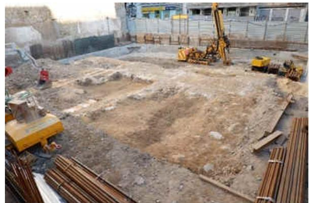
Figura 5 – Vista geral da área de intervenção com alicerces dos edifícios agora demolidos.
