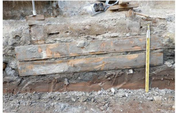
Figura 7 – Taipais em madeira usados na base do muro [1002].
