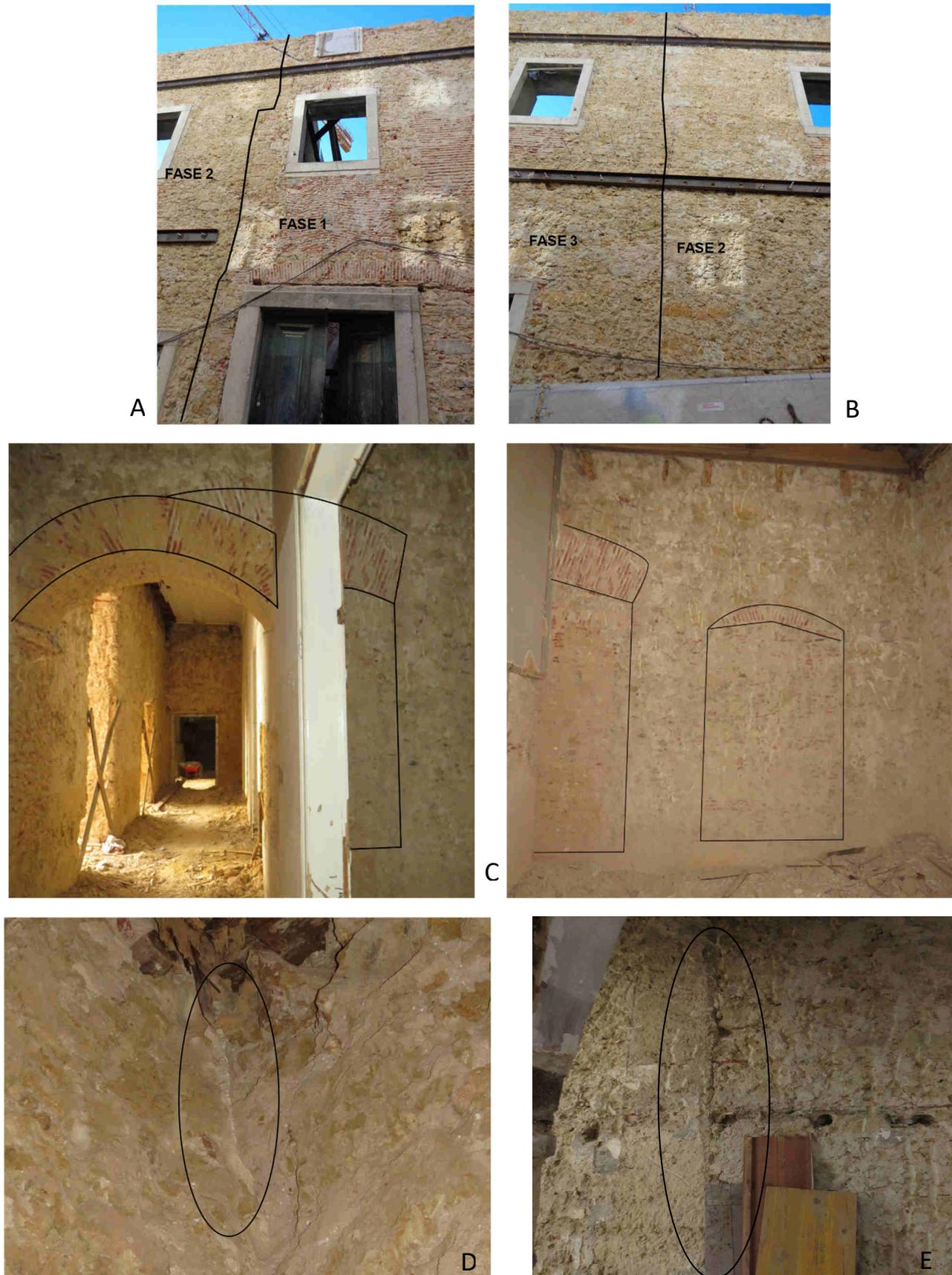
Figura 11 – (A) Aspecto da fachada exterior voltada à Travessa José Vaz de Carvalho (pormenor da zona a poente): contacto entre as fases 1 e 2 do edificado. (B) Aspecto da fachada voltada à Travessa José Vaz de Carvalho (pormenor do edifício a nascente): contacto entre as fases 2 e 3 do edificado. (C) Vistas gerais da parede 1, onde termina a Fase 2 (or NW). (D) Pormenor de reboco na ligação da Parede 1 com a Parede 2. (E) Pormenor de ligação entre duas paredes na Parede 4, vista do pátio.
