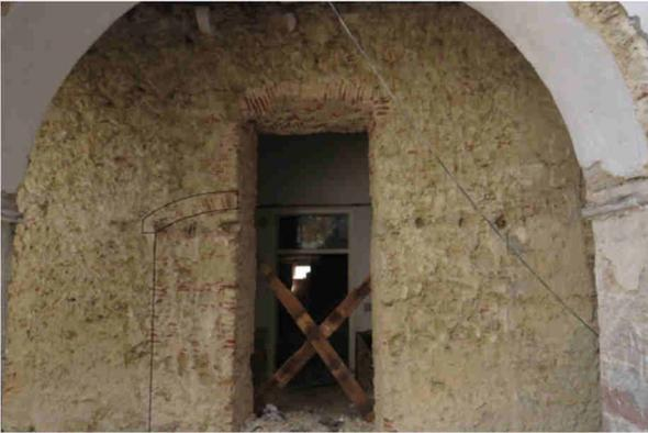
Figura 12 – Pormenor de antigo vão entaipado e parcialmente desmontado, Parede 4.
