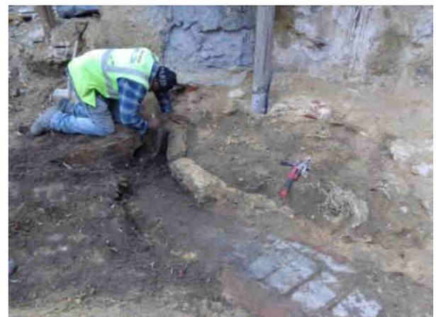
Figura 23 – Limpeza e escavação manual do caneiro [A814] que faz ligação à estrutura afunilada localizada no compartimento contíguo a este espaço.
