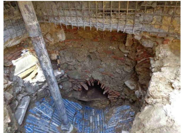
Figura 22 – Perspectiva da parede SE com uma estrutura tipo caneiro conduzindo água a partir da estrutura afunilada.
